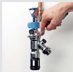
2. Halteklammer mit einem Schraubenzieher herausziehen
